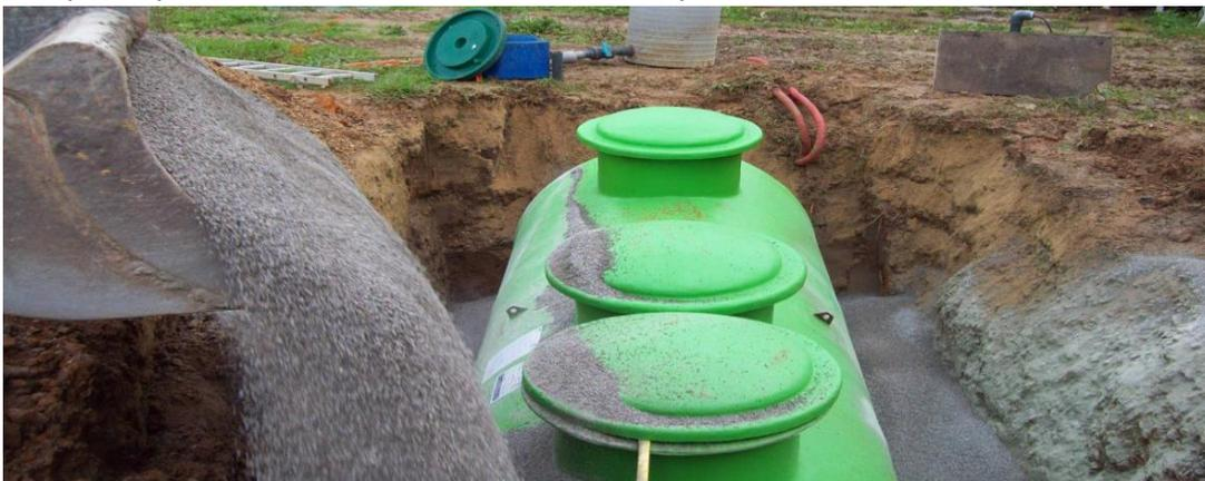
Si l'installation la nécessite, des rehausses (Polyéthylène, hauteur 30 cm, à visser sur l'accès en place) peuvent être prévues. Le dispositif ne doit pas être complété d'une rehausse telle que la hauteur de remblai soit supérieure à 20 cm pour Stepeco 5 EH en PEHD et 10 cm pour Stepeco 5 EH en PRV (sauf dalle de répartition dimensionnée par un bureau d'études)
