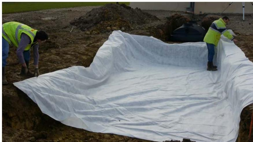
Figure 24 – Installation du géotextile antipoinçonnant
