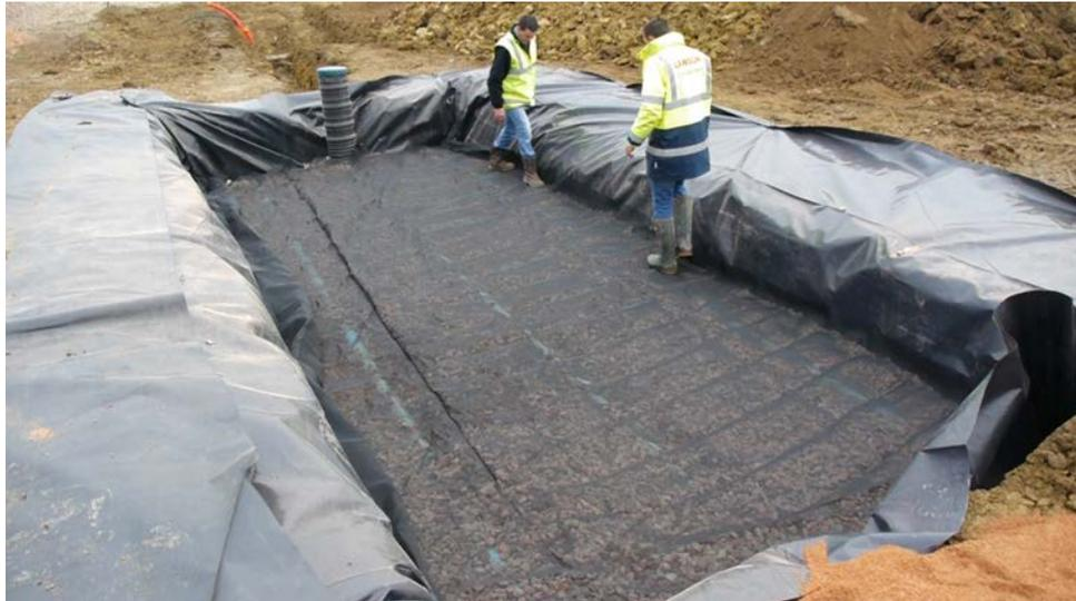
Figure 32– Mise en place de la grille de filtration
