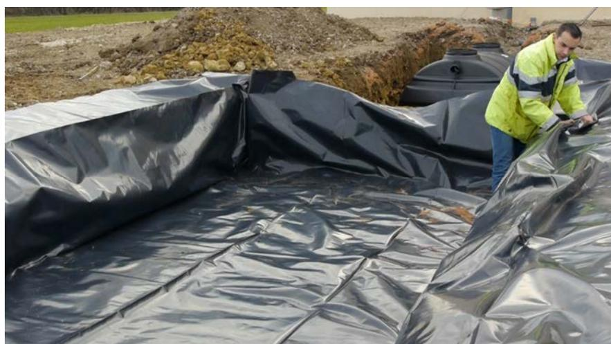
Figure 25 – Installation du film de PEHD 400 µm réel
