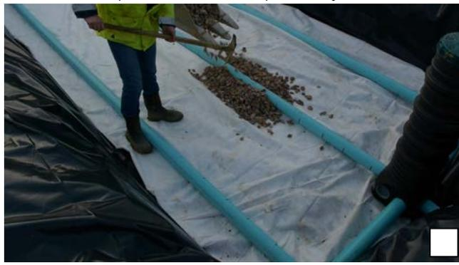
Ajouter les conduites étanches, le gravier lavé 10/40 mm et le dispositif de collecte et d'échantillonnage.
