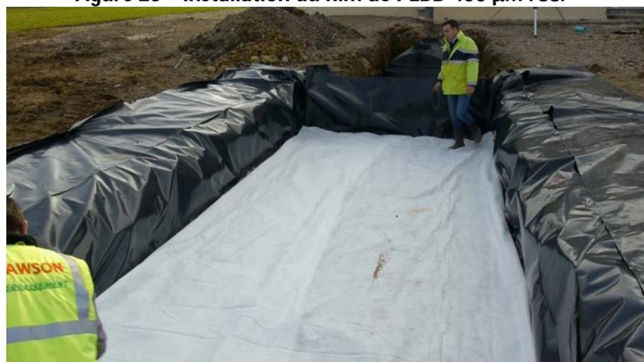
Figure 26 – Installation du géotextile anticontaminant
