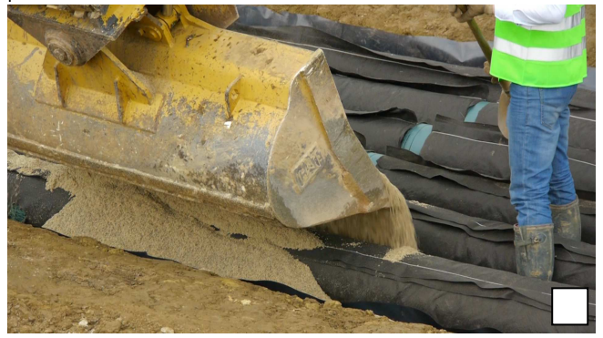
Stabiliser les rangées de conduites en plaçant du sable filtrant vis-à-vis des manchons.
