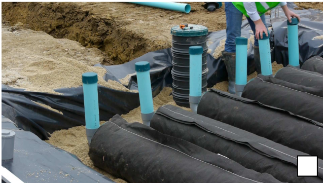
Poser les piézomètres, ajouter du sable et bien compacter. Garder les conduites des piézomètres au niveau.
