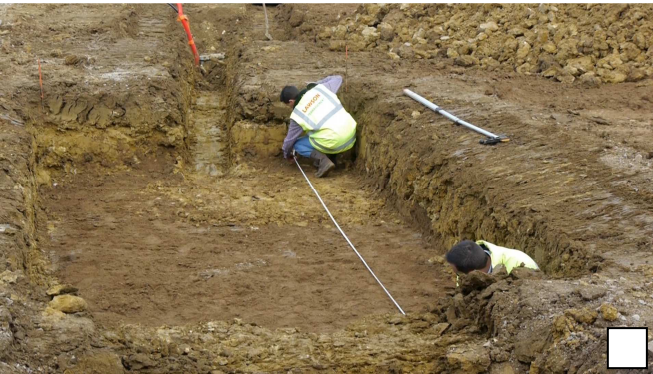
Excaver selon la profondeur inscrite au plan. Préparer le sol récepteur en le mettant à niveau.
