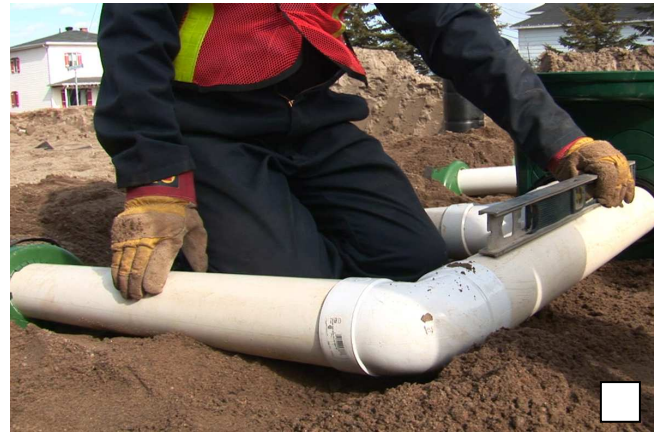
Mettre le regard de répartition au niveau sur tous les axes. La raccorder aux conduites en maintenant une pente de 1%.
