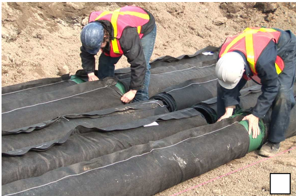
Placer les conduites sur la surface et les raccorder entre elles à l'aide des manchons. Replacer les membranes.
