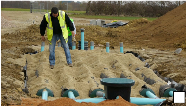
Ajouter du sable filtrant à mi-hauteur des conduites et marcher le long des rangées pour bien placer le sable filtrant
