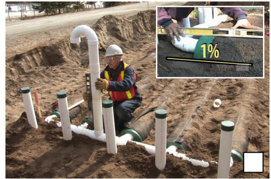
Poser le système de ventilation en maintenant une pente de 1% vers les conduites Advanced Enviro-Septic.
