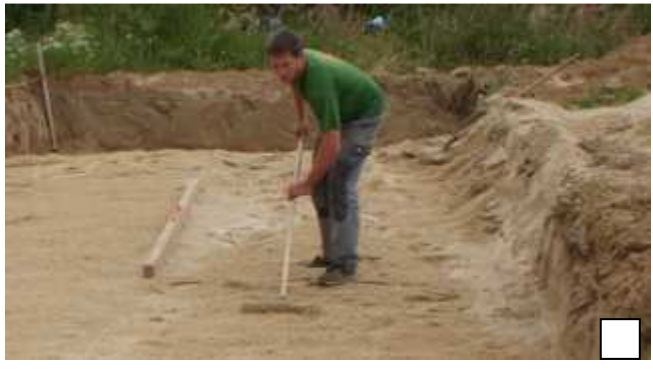
Mettre une couche 30 cm de sable lavé assainissement de niveau sur laquelle sera placée les rangées de conduites.
