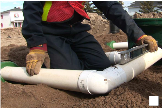
Mettre le regard de répartition au niveau sur tous les axes. La raccorder aux conduites en maintenant une pente de 1%.
