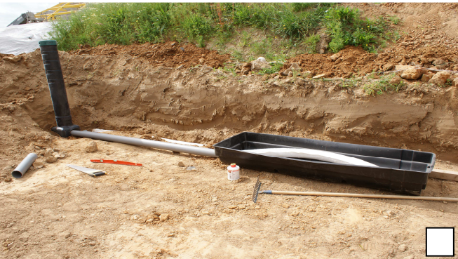
Placer le dispositif l'échantillonneur et le gravier 10/40 dans le cas d'un sol de perméabilité médiocre.
