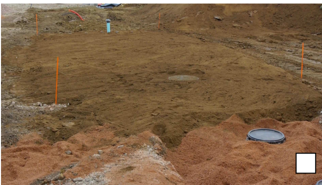
Compléter le remblayage en vous assurant que les remblais sont conformes au plan et recouvrir la surface de végétation herbacée.
