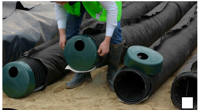
Installer les adaptateurs décentrés en prenant soin de bien remettre en place les membranes.
