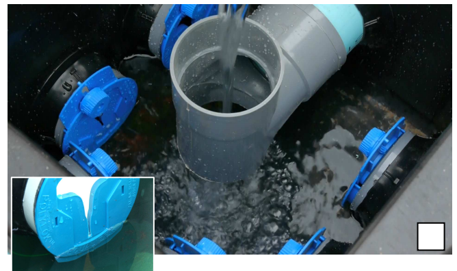
Verser de l'eau dans le regard de répartition. Calibrer les égalisateurs en ajustant les molettes.
