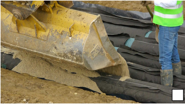
Stabiliser les rangées de conduites en plaçant du sable filtrant vis-à-vis des manchons.
