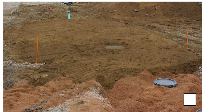
Mettre le regard de répartition au niveau sur tous les axes. La raccorder aux conduites en maintenant une pente de 1%.
