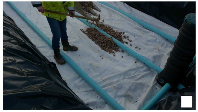
Ajouter les conduites étanches, le gravier lavé 10/40 mm et le dispositif de collecte et d'échantillonnage. la grille de séparation est positionnée au-dessus du gravier..
