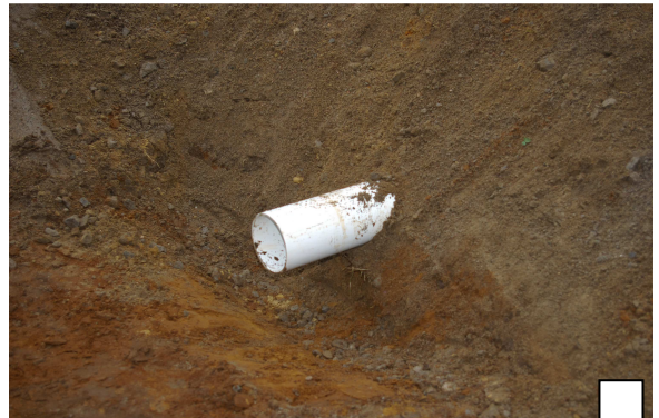
Mettre en place la conduite de sortie par gravité du système qui reçoit les eaux collectées et qui les achemine vers le point de rejet.
