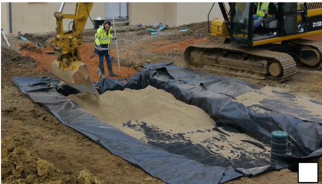
Compléter la mise en place de la couche de sable filtrant sur laquelle seront installées les rangées de conduites.
