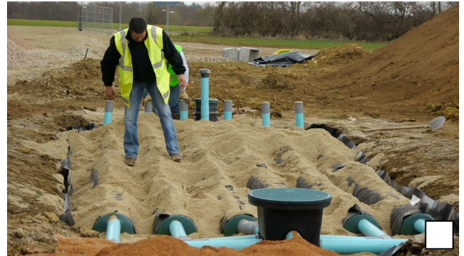
Ajouter du sable filtrant à mi-hauteur des conduites et marcher le long des rangées pour bien placer le sable filtrant
