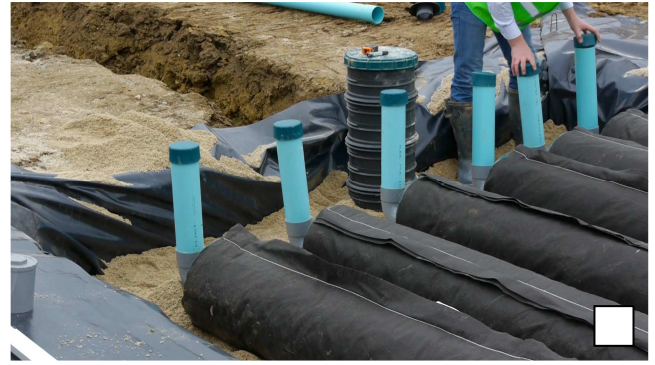
Poser les piézomètres, ajouter du sable et bien compacter. Garder les conduites des piézomètres au niveau.
