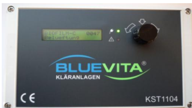
Figure 7 : Panneaux de commande KST 1003 et KST 1104 avec écran à 2 lignes pour l'affichage de l'état du système
