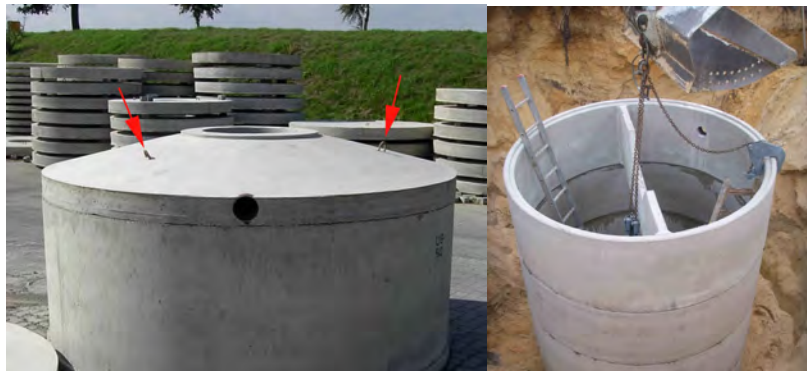
Image : levage des éléments en béton, points d'ancrage du cône
