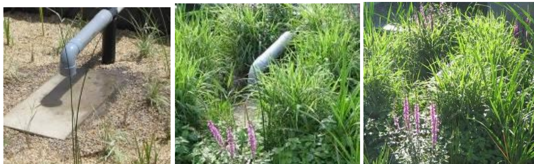
Illustration 11. Le point de distribution des effluents bruts dans une Phytostation 6 EH : prise de vue en démarrage (gauche), sept semaines après (milieu) et huit semaines après (droite).
