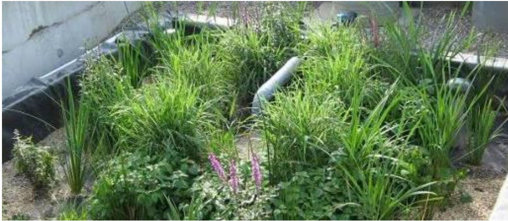
Illustration 13. Une prise de vue du filtre vertical d'une Phytostation 6 EH, sept semaines après l'installation.
