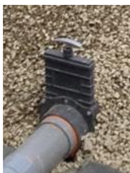
Illustration 22. Vanne de sectionnement inter-filtres.
