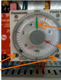
3. placer l'aiguille verte en fonction des minutes de recirculation des boues
