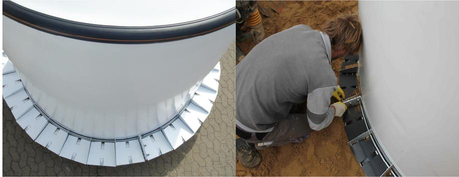
Figure 13: le montage d'ancrage pour les zones à nappe phréatique
