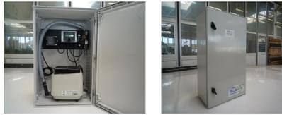
Figure 8: La boîte de commande ou de pilotage interne «l'armoire en PRV»
