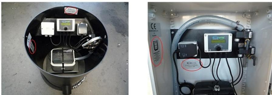
Figure 2: Boîtes de commande ou de pilotage avec le numéro de traçabilité
