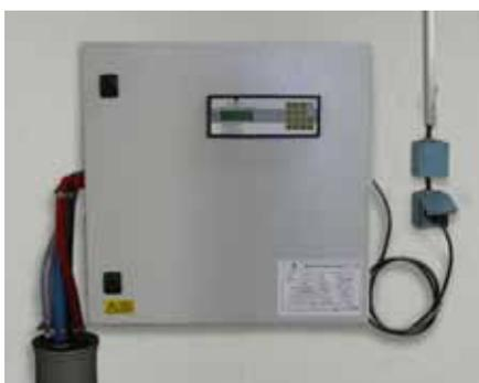
Installation de l'armoire de commande intérieure métallique.
