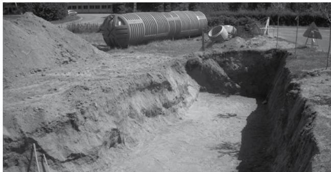
La terre végétale de la zone d'installation doit être décapée soigneusement et stockée dans une zone réservée à cet effet pour permettre la finition en fin de travaux.
