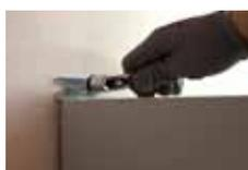
1. Préparer l'armoire en pré-montant avec les vis HM8x15 les supports muraux de fixation ci-contre fournis avec le kit (Art. : 35261 - livré avec l'armoire intérieure métallique Art. 34802) aux quatre coins au dos de l'armoire.
