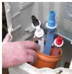
1. Mettre 2 tours de bande Téflon sur le filetage des douilles cannelées pour éviter les pertes d'étanchéité.
