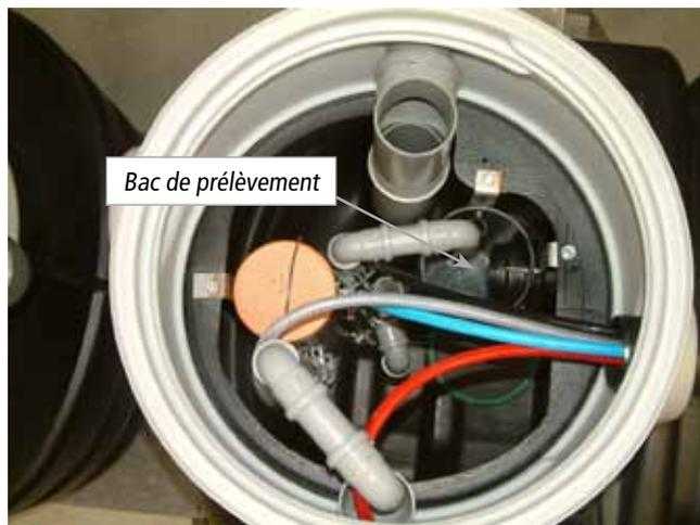
Vue du dessus d'une rehausse de micro-station ACTIBLOC® 20EH (18000 DP) avec bac de prélèvement dans le réacteur.
