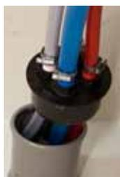
1. Mettre 2 tours de bande Téflon sur le filetage des douilles cannelées pour éviter les pertes d'étanchéité.
