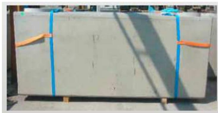
**Figure 7 : Exemple du montage des sangles**
