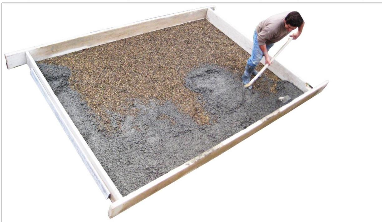
Réalisation du coffrage et début de réalisation de la dalle béton
