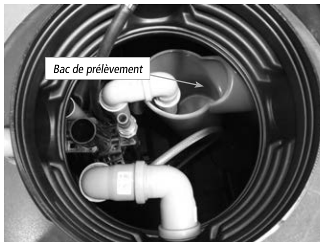
Vue du dessus d'une rehausse de micro-station ACTIBLOC® LT 40-40 10EH avec bac de prélèvement dans le réacteur.
