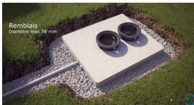
Fig-30 : Remblaiement
