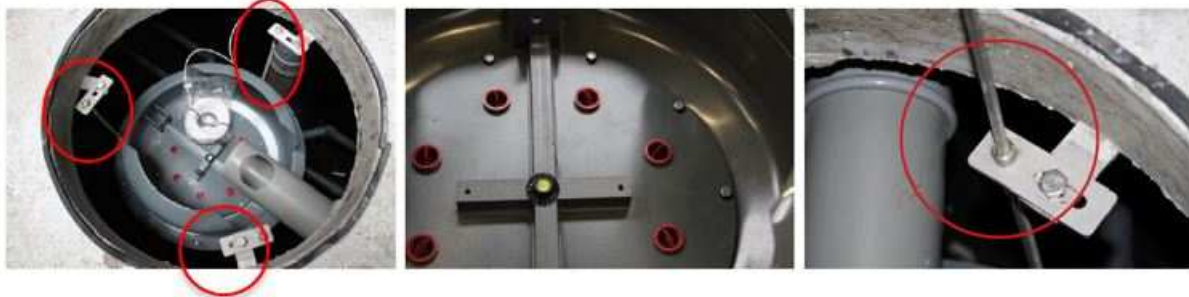
Fig-34 : Vis de réglage du système de distribution à auget basculant
