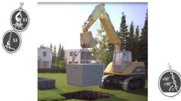
Fig-19 : Manutention de cuve
