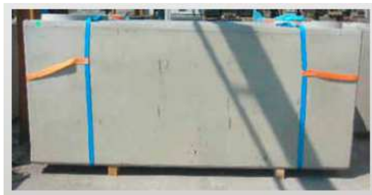
Figure 42 : Exemple du montage des sangles (extraits du document Notice d'assemblage des sangles de levage en annexe)
