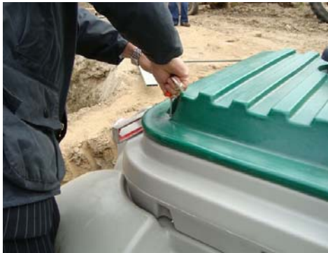
Figure 9 : Finale, plaque isolante et verrouillage couvercle
