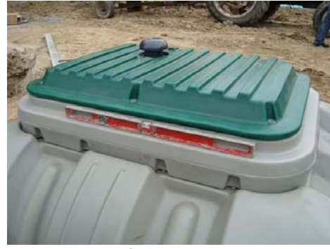
Figure 5 : Vérification des niveaux
