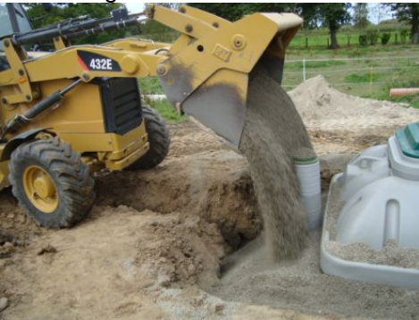
Figure 6 : Mise en place réhausse, boîte et épandage
