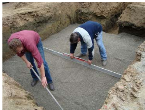
Figure 3 : Nivellement du gravier
