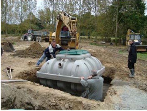
Figure 4 : Pose du filtre
