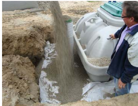
Figure 7 : Mise en place du géotextile anticontaminant et remblai
