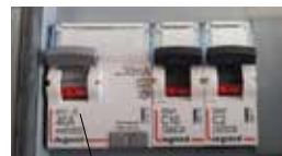
Disjoncteur remonté
