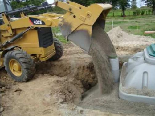
Figure 6 : Mise en place réhausse, boîte et épandage
