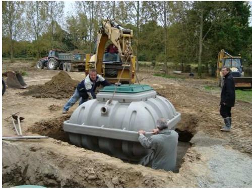
Figure 4 : Pose du filtre
