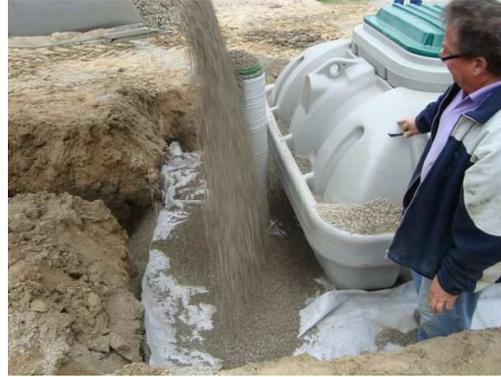
Figure 7 : Mise en place du géotextile anticontaminant et remblai
