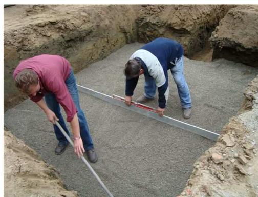
Figure 3 : Nivellement du gravier
