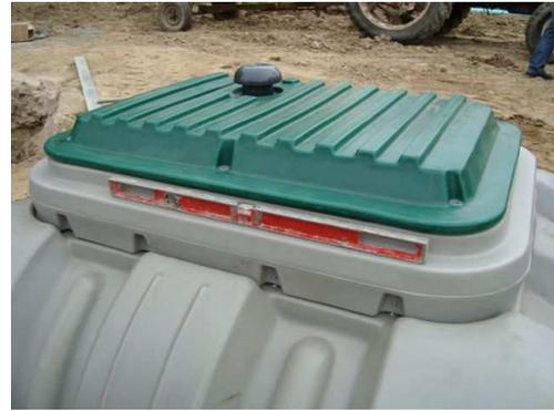
Figure 5 : Vérification des niveaux
