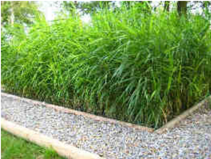
Filtre vertical en saison végétale (la grille est camouflée par les roseaux)
