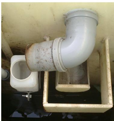
Un échantillon ponctuel d'eau épurée peut être prélevé au niveau de la sortie des eaux traitées située dans le bassin d'accumulation de la manière suivante :
