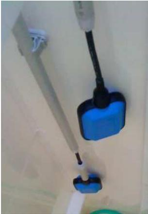
Les contacts à flotteurs sont des détecteurs de niveau liquide efficaces et économiques. Simples à installer, ils sont conçus pour un fonctionnement fiable de longue durée. Le flotteur type LR03 est en matériau plastique moulé à un câble à 3 brins avec une gaine en PVC ou caoutchouc synthétique. Le déclenchement se fait via une bille mobile et un micro interrupteur éliminant tous les métaux lourds.
