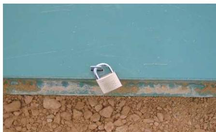
**Le couvercle a été testé pour supporter une charge piétonne de 200 kg/m<sup>2</sup> maximum, néanmoins éviter toutes charges roulantes ou statiques sur le couvercle et à moins de 2 m de la station.**
