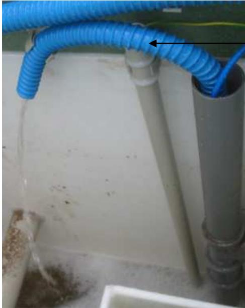
Pompe airlift d'aspiration des matières en suspension du filtre à sable vers le bassin d'accumulation.
