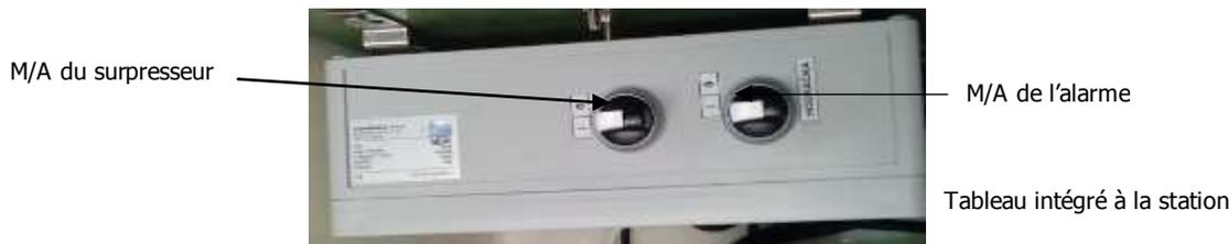
On contrôlera également le fonctionnement des interrupteurs situés sur le tableau intégré à la mini station.
