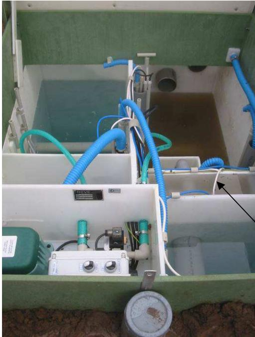
Mettre en place le sable dans le compartiment du filtre à sable.
