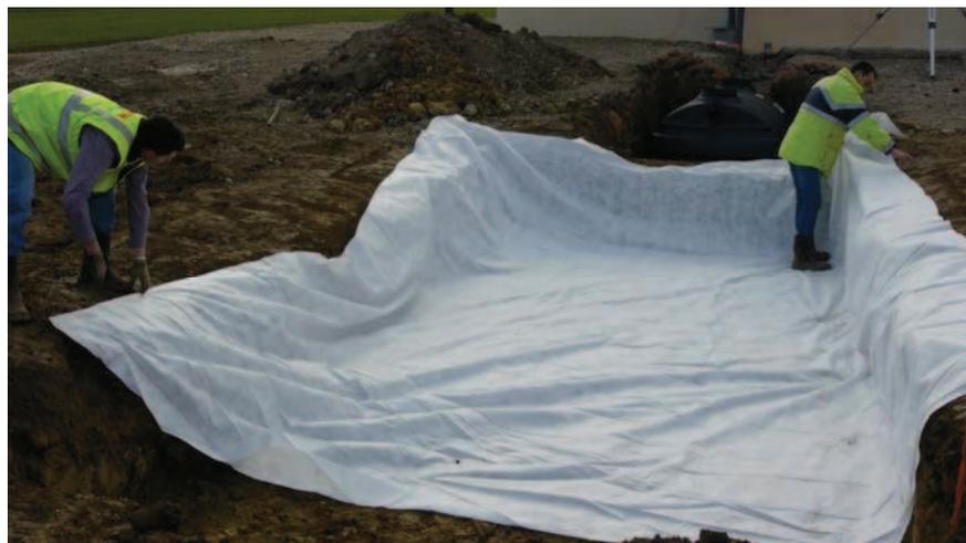
Figure 24 – Installation du géotextile antipoinçonnant
