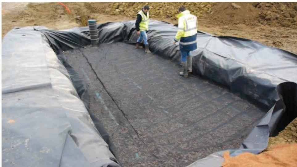
Figure 32– Mise en place de la grille de filtration
