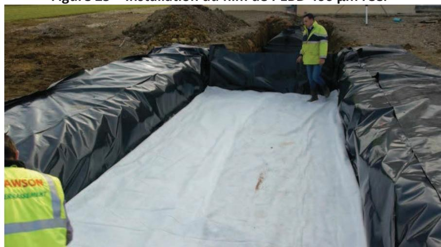
Figure 26 – Installation du géotextile anticontaminant
