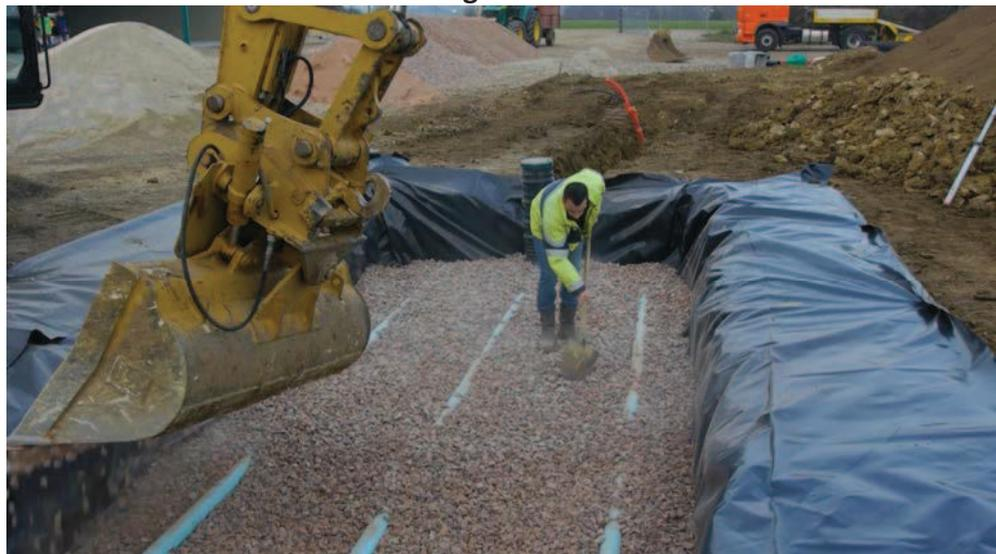
Figure 31 – Mise en place de la pierre concassée lavée 10/40 mm
