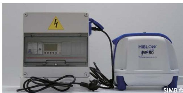
3 – Raccorder le tuyau d'air venant de la station au surpresseur. (Vérifier qu'il ne se coude pas)
