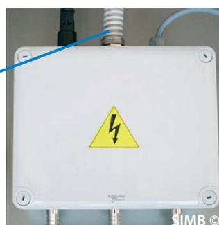
4 – Raccorder le tableau électrique au réseau soit sur une prise d'alimentation 50/60Hz ; 220-240V, soit au tableau général du bâtiment. (protégé par un disjoncteur)
