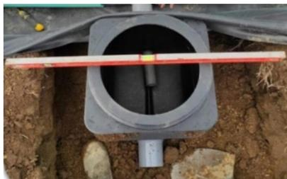
Installer le regard de niveau, sur un lit de pose. S'assurer de la planéité.
