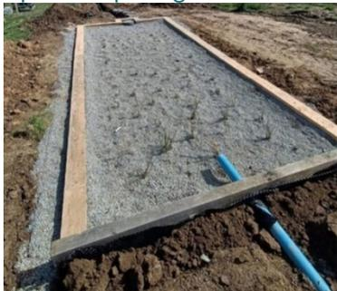
Pour cela, percer le cadre rigide avec une scie cloche ou la membrane pour faire passer le tuyau d'alimentation. Le perçage se fait en DN100. Le fil d'eau entrée / sortie du filtre est de 50 cm, soit 40 cm de matériau filtrant et 10 cm de revanche (distance entre le bas du tuyau d'alimentation et la surface des graviers filtrants).
