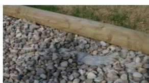
Il est également possible de recouvrir intégralement le tuyau d'une couche de graviers. Dans ce cas, s'assurer que le tuyau n'est plus visible.
