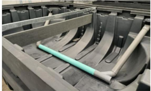
Exemple de mise en place du réseau de drainage du filtre à écoulement vertical = filtre à roseaux
