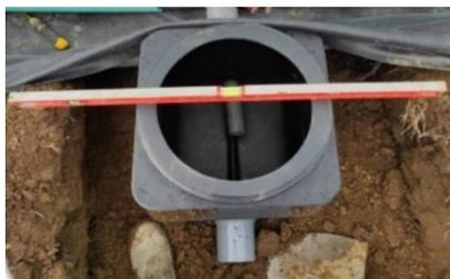
Installer le regard de niveau, sur un lit de pose. S'assurer de la planéité. Ajouter éventuellement des réhausses à visser (se référer au paragraphe « Modalités de prélèvement d'un échantillon » p. 23), établir les connexions puis remblayer avec de la terre végétale débarrassée de tout élément caillouteux ou pointu. Le remblaiement est réalisé par couches successives jusqu'à une hauteur suffisante au-dessus du sol, de part et d'autre du tampon, pour tenir compte du tassement ultérieur.
