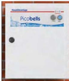
*Armoire de commande « Premium Outdoor » pour installation à l'extérieur avec le panneau de commande Premium (IP 65)*
