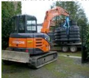
**Levage de la cuve : utiliser les points d'ancrage uniquement.**
