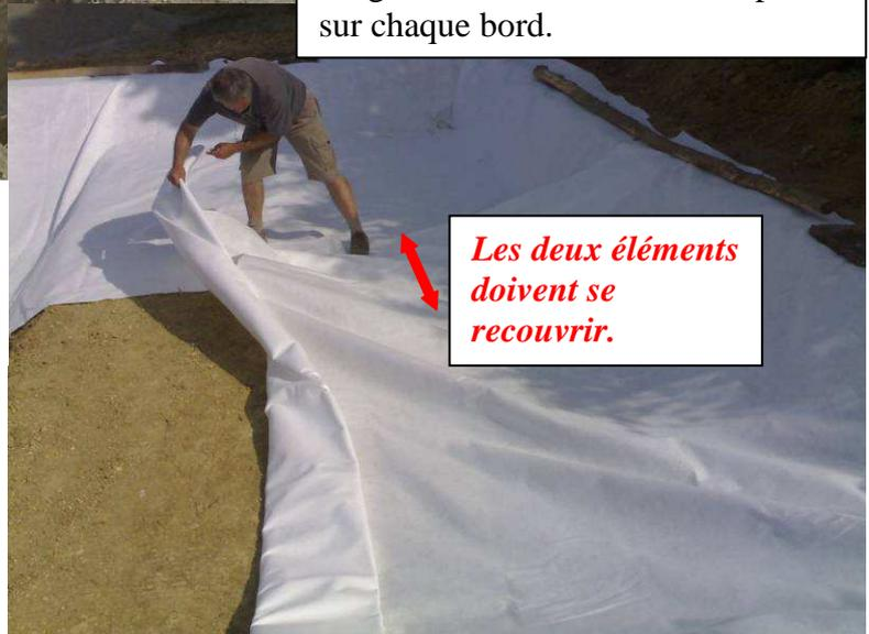
**Les deux éléments doivent se recouvrir.**
