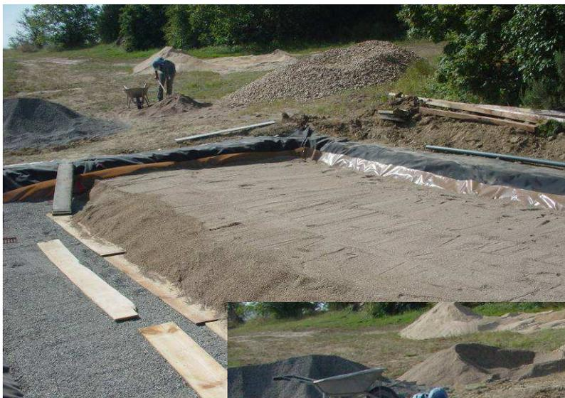
*Photo 22: Réglage du niveau fini du filtre (1)*
