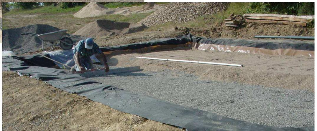
*Photo 23 : Réglage du niveau fini du filtre (2)*
