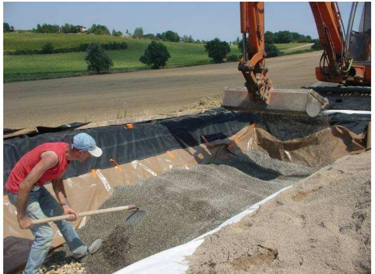
*Photo 21 : Remplissage en gravier du compartiment horizontal (1)*
