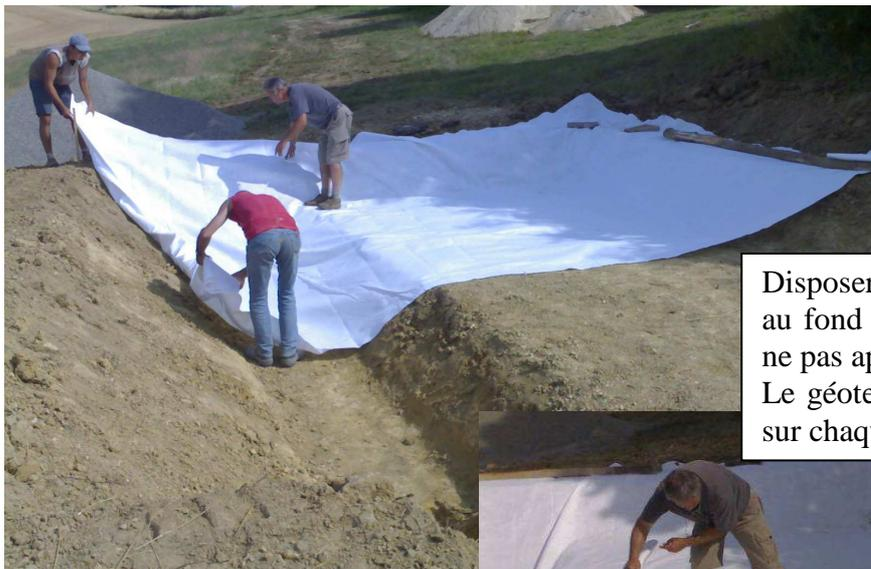
*Photo 3 : Application du géotextile et recouvrement des lés (1)*
