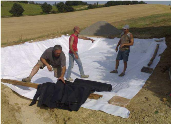
Une fois le rouleau de géomembrane positionné au fond du bassin, comme sur le plan de pose fourni par CULTISOL...
