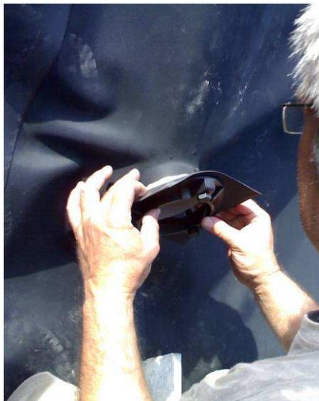
*Photo 18 : Pose de la collerette d'étanchéité*
