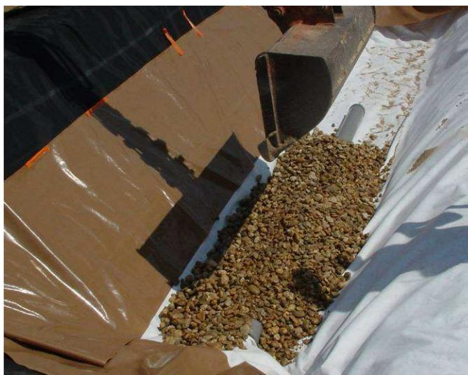
Photo 20 : Enrobage du drain de collecte en graviers 20/40
