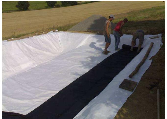
... dérouler le rouleau de géomembrane en pied de talus du compartiment vertical pour pouvoir couvrir les pentes du bassin.
