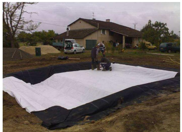
Photo 14 : pose du géotextile supérieur
