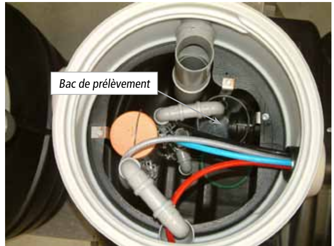
Vue du dessus d'une rehausse de micro-station ACTIBLOC® 4EH (2500-2500 SL) avec bac de prélèvement dans le réacteur.
