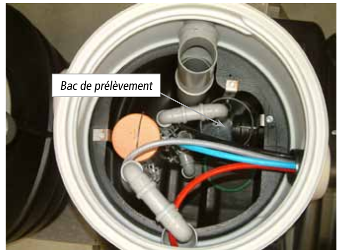
Vue du dessus d'une rehausse de micro-station ACTIBLOC® 4EH (3500-2500 SL) avec bac de prélèvement dans le réacteur.
