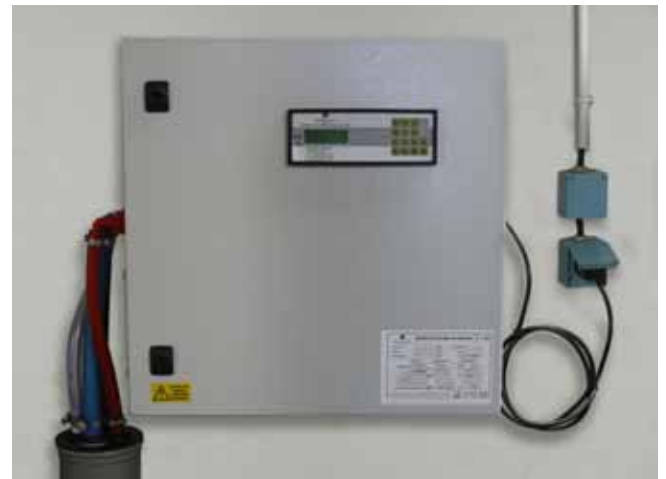
Armoire de commande intérieure métallique fermée (Art.: 32732 - vendue séparément).
