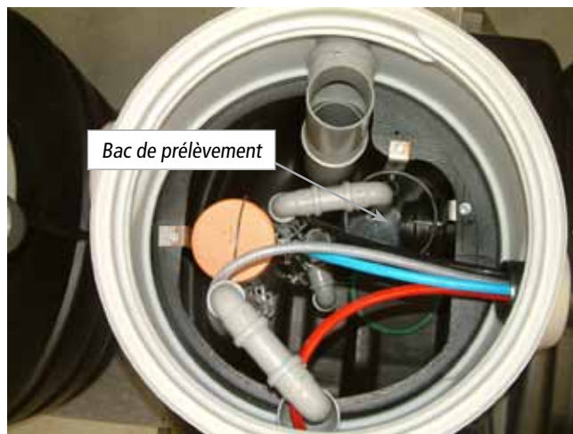
Vue du dessus d'une rehausse de micro-station ACTIBLOC® 6EH (6000 DP) avec bac de prélèvement.
