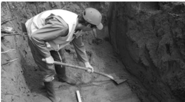
Dans le cas de sols difficiles (exemple : imperméable, argileux, etc.) ou d'une nappe, le lit de pose doit être réalisé avec du sable stabilisé armé sur une épaisseur de 0,30 m. En cas de jumelage de cuves, il est impératif de réaliser un radier en sable stabilisé armé sur une épaisseur de 0,30 m et de soutenir les tubes et raccords de connexion par un lit de sable stabilisé.
