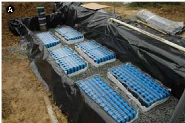
B. Remplissage autour des modules EPANBLOC® de gravier de calage lavé, stable à l'eau, de granulométrie 10-40 mm sur une épaisseur de 0.25 m. Elle assure à la fois l'oxygénation du massif et permet d'augmenter la surface d'infiltration, tout en évitant le colmatage de l'EPANBLOC®.
