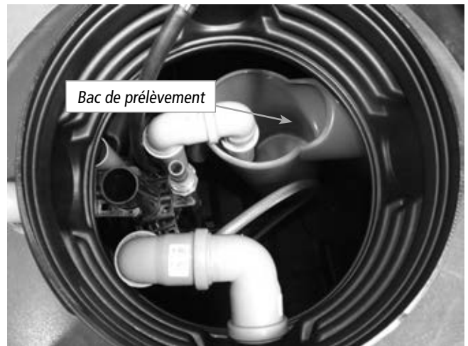
Vue du dessus d'une rehausse de micro-station ACTIBLOC® LT 30-35 8EH avec bac de prélèvement dans le réacteur.
