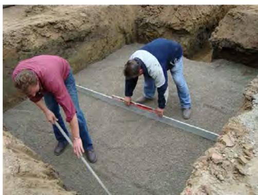
Figure 2 : Nivellement du gravier
