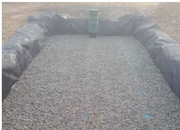
Figure 11 : Mise en place du gravier lavé 10/40 mm
