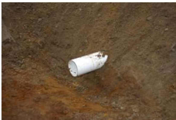
Figure 5 : Conduite de sortie par gravité
