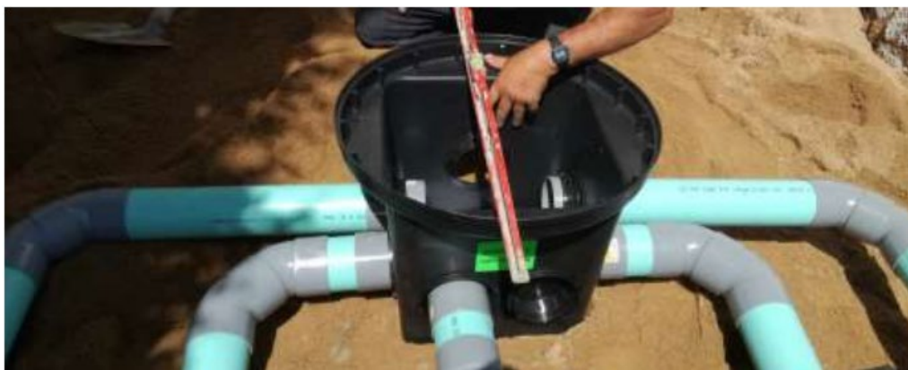
Figure 15 : Exemple d'un regard de répartition installé et connecté hydrauliquement aux cavités des unités de traitement HBX
