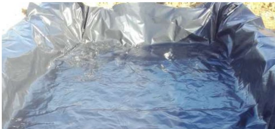
Figure 6 : Installation de la membrane étanche
