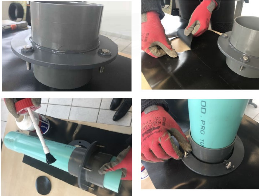
Figure 7 : Pose de la collerette étanche DBO France
