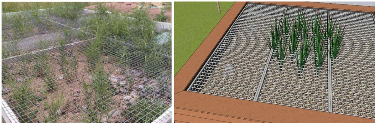
Une photo montrant la grille fixée sur le filtre vertical (illustration à gauche). Une image 3D illustrant un filtre vertical avec une grille fixée horizontalement à sa surface (illustration à droite).
