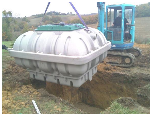
Exemples de Transport et manutention
