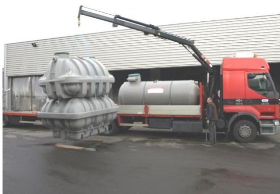
Exemple de manutention d'un assemblage fosse et filtre EPURFIX® Polyéthylène
