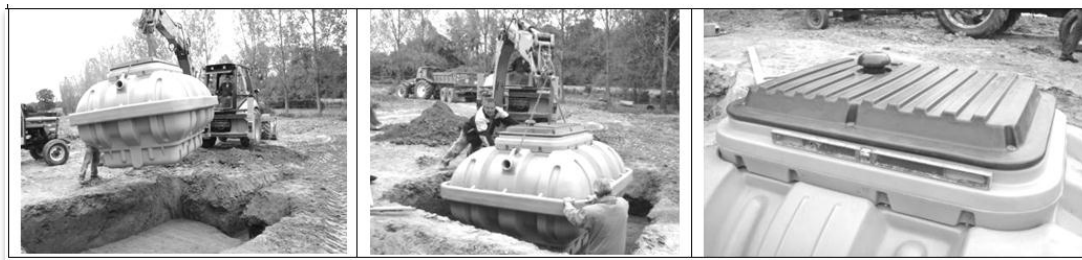
Mise en fouille de l'EPURFIX® Polyéthylène
