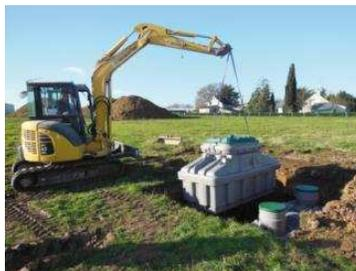
**Figure A6 - Exemples de manutention d'un module ECOFLO® PE1**
