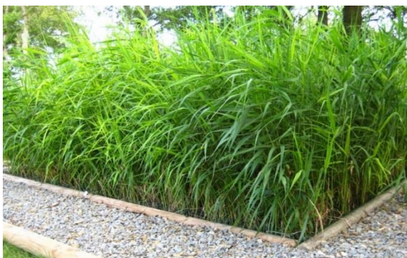
Filtre à écoulement vertical en saison végétative (la grille est camouflée par les roseaux)
