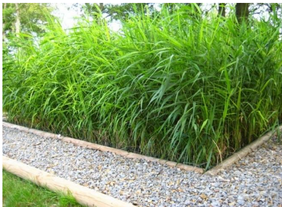
Filtre à écoulement vertical en saison végétative (la grille est camouflée par les roseaux)
