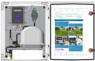
Le coffret de commande est activé lors de la mise en service par le professionnel qualifié via la procédure établie par FRANCE EUROPE ASSAINISSEMENT (procédure en annexe 3 de ce guide et se trouvant dans l'armoire électrique de votre dispositif) permettant d'assurer la traçabilité de la station et de démarrer la garantie. Après avoir effectué tous branchements, le professionnel contactera FRANCE EUROPE ASSAINISSEMENT afin d'obtenir un code d'activation de la station.
