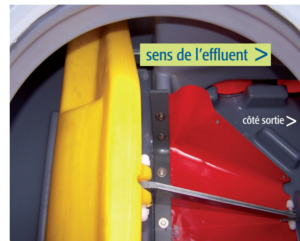
Position ouverte (Flotteur niveau haut, trappe ouverte)
